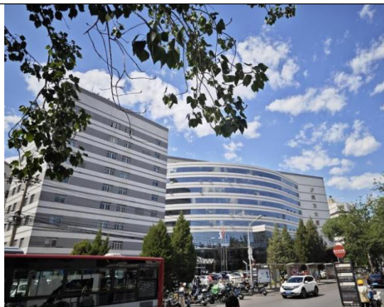
本项目所在建筑：同方大厦
