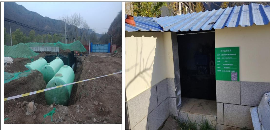
污水处理站施工阶段清水罐（现状埋于地下）及污水站站房
