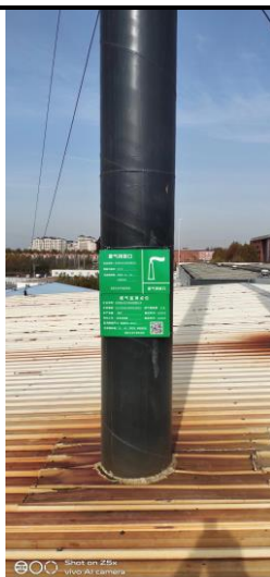
锅炉废气排气筒
