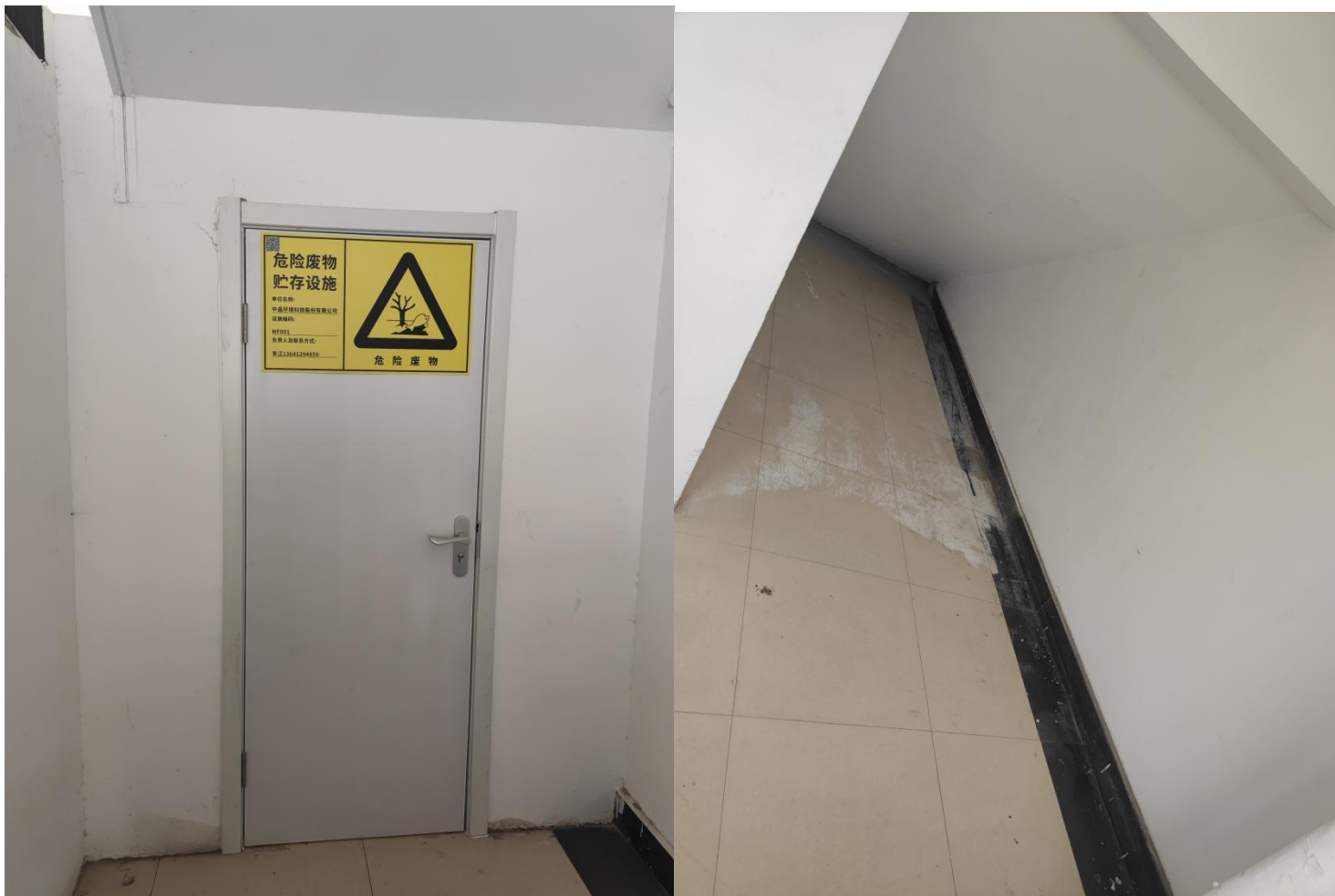
附图 3 危险废物暂存间照片
