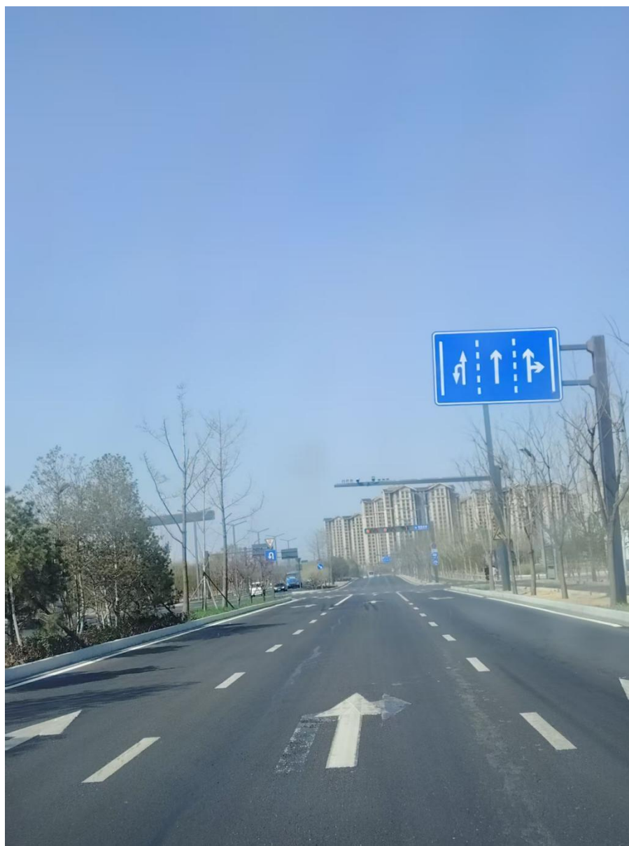
沥青混凝土路面现状
